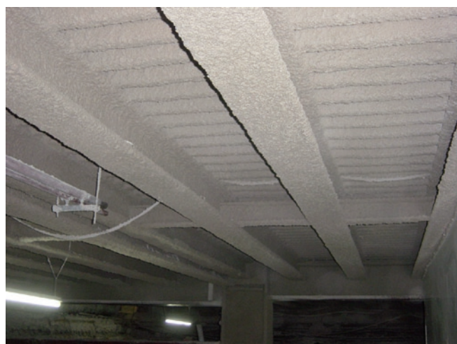
Aplicación de Igniplaster en un restaurante.
