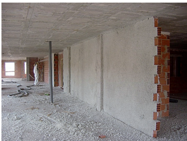
Aplicación de aislante térmico-acústico en una medianera.
