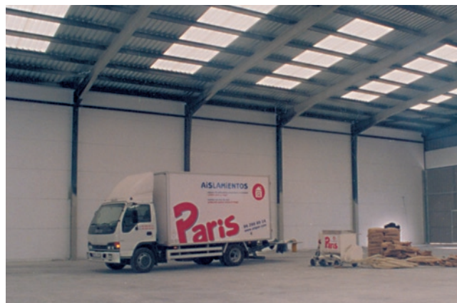
Trabajos de aplicación de MLR mediante proyección.
